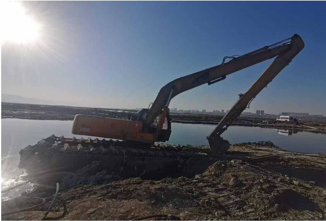
图五 挖泥船全貌
