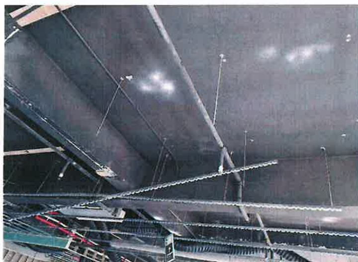
图4 事发现场顶部的轻钢龙骨
